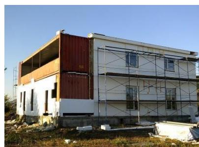
Это позволяет создавать строительный каркас здания из самых дешевых материалов, повышая затем качество здания за счет современных технологий энергосбережения.
