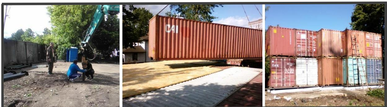
Как правило, достаточно 30 дней чтобы полностью построить со всеми инженерными системами и внутренней отделкой дом общей площадью 320 м<sup>2</sup>, состоящий из 10 морских контейнеров. При этом высота потолков составит не менее 2,7 метра при использовании контейнеров марки HQ.
