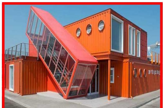
В действительности морской транспортный контейнер представляет собой высокопрочный металлический каркас, изготовленный из особой марки стали (кортеновская сталь – COR-TEN steel) препятствующей развитию процесса естественного ржавления за счет своих уникальных свойств. Кортеновская сталь применяется в судостроении, промышленном и гражданском строительстве как конструкционный и декоративный материал.
