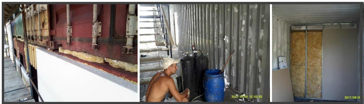
На фото приведены примеры звукоизоляции: пенополистирольной плитой (внешние стены), пеноизолом (внутренние стены), минеральной ватой (межэтажные пространства и внутренние перегородки).
