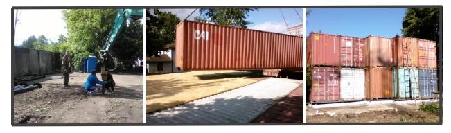
Как правило, достаточно 30 дней чтобы полностью построить со всеми инженерными системами и внутренней отделкой дом общей площадью 320 м2, состоящий из 10 морских контейнеров. При этом высота потолков составит не менее 2,7 метра при использовании контейнеров марки HQ.
