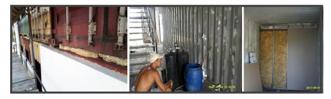
На фото приведены примеры звукоизоляции: пенополистирольной плитой (внешние стены), пеноизолом (внутренние стены), минеральной ватой (межэтажные пространства и внутренние перегородки.
